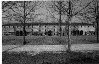
Ekonomibyggnadens södra fasad, färdigställd under 1800-talet. (25)
