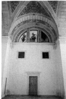
Vägg i den korsformade hallen. (17)
