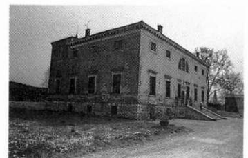
Fasaden mot norr. (12)
