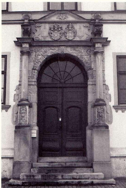
Figur 3. Länsresidensets portal i Göteborg. Den nuvarande portalen är en nyhuggen kopia av den ursprungliga, vilken demonterades på 1970-talet på grund av kraftiga vittringsskador. Den ursprungliga portalen skulpterades i lösa delar som sammanfogades på plats under år 1649. För stenarbetena svarade sannolikt Christian Pfundt ("Christian Stenhuggare"). Stenarbetena är av mycket hög kvalitet och objektet är ur flera avseenden att betrakta som synnerligen unikt. Endast ett fåtal arbeten i landet skulle kunna mäta sig med den tekniska och konstnärliga kvaliteten i denna portal.
