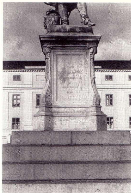
Figur 4. Sockeln till Gustav II Adolf-statyn i Göteborg från 1800-talets mitt är utförd i Carraramarmor, huggen av svenskfödd bildhuggare Lundberg i Italien och levererad till Göteborg i monteringsfärdigt skick.
