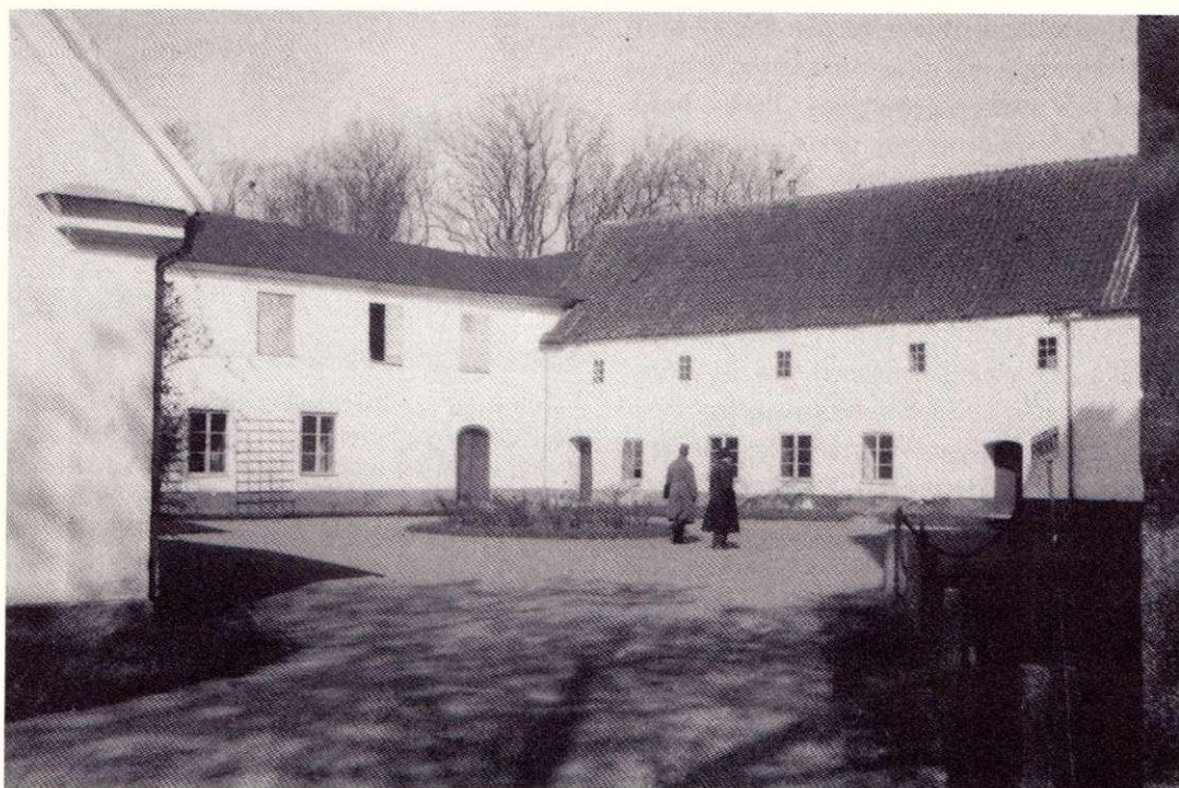
Borggården mot öster 1937 före restaureringsarbetena.
