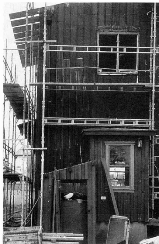
För att demontera ytterpanelen restes ställningar runt Röda Ladan.
