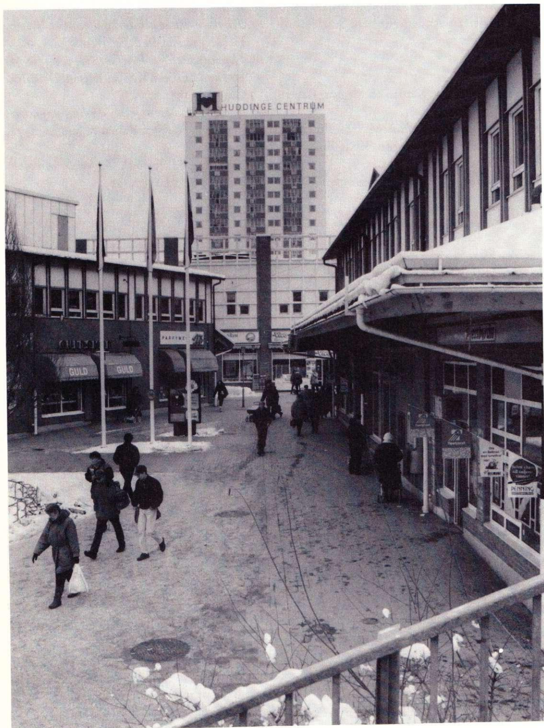
Huddinge Centrum byggdes om i slutet av åttiotalet.
