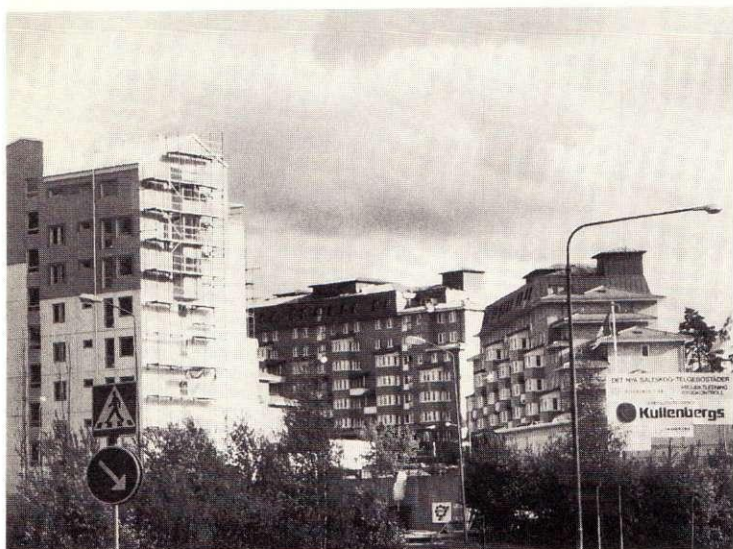
Barrtorpsvägen och Myntstigen under ombyggnad.
