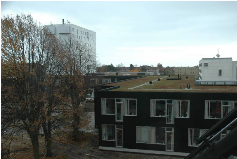
Figur 10: Med det nye institutionsbyggeri er uderummene i Gyldenrisparken blevet underdelt i et forløb af mindre rum , der hver især er klart definerede og dermed lettere at indtage for beboerne. Institutionsbygningernes grønne tagflader kan ses fra de øverste lejligheder i bebyggelsen.
