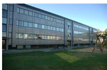
Figur 12: Billeder fra «før» og «efte» en række renoveringer i en række danske almene bebyggelser. Kvaliteten af de gennemførte renoveringer er meget varierende.
