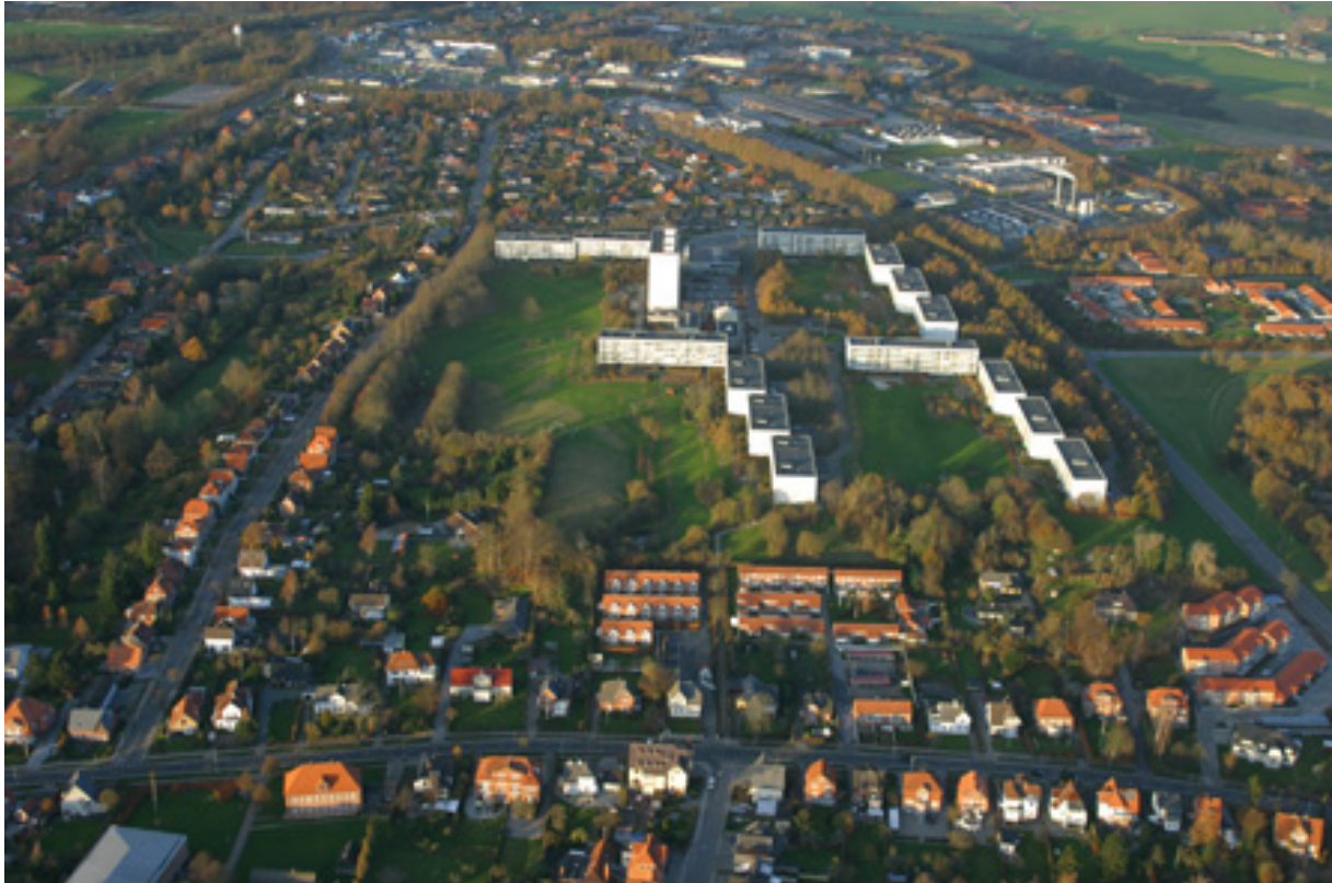
Figur 6: Varbergparken i Haderslev før renovering. Bebyggelsen skiller sig arkitektonisk og skalamæssigt ud i forhold til omgivelserne. Bebyggelsen er omkranset af høje træer og kun med en enkelt adgangsvej fører til bebyggelsen .
