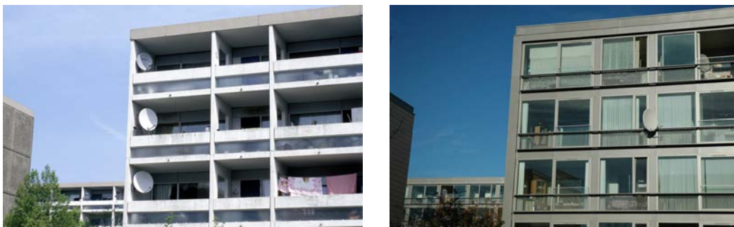
Figur 3: En af de evaluerede bebyggelser, «Bispehaven» i Århus. Altanerne er blevet inddækket af glas, og derved er bygningernes oprindelige arkitektoniske kvaliteter forsvundet.
