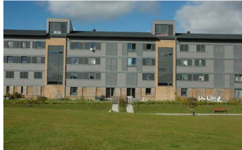
Figur 7: Vejleåparken rummer 2000 boliger. Til venstre et billede af en af boligblokkene før den gennemførte renovering . Billedet til højre er taget efter renoveringen.
