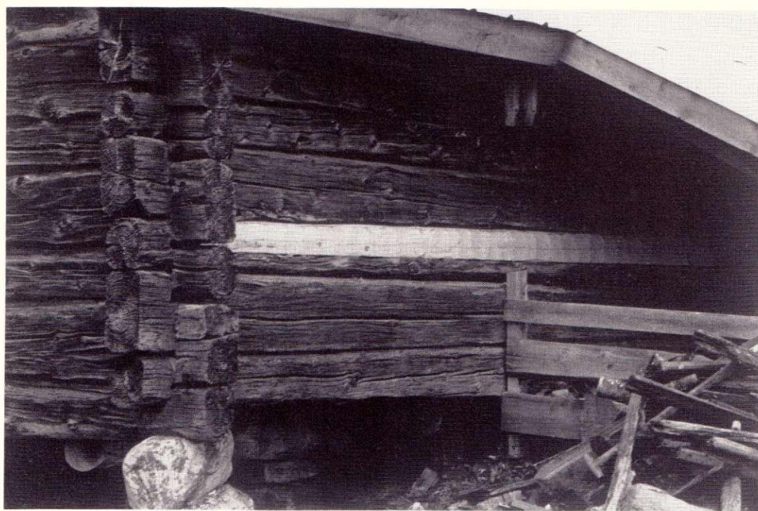
Ilagning i väggstock. Fåhus, Långbodarna, Bergs kn, Jämtlands län.
