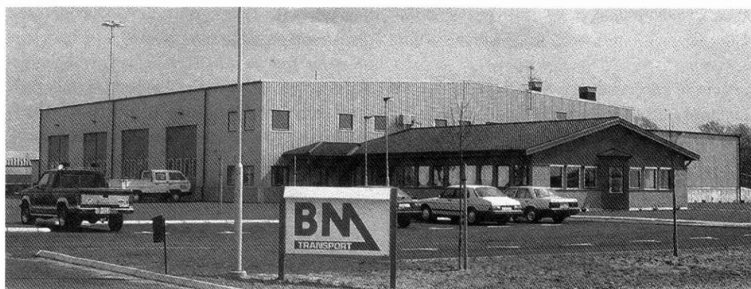
Ett typiskt industrihus med en hallbyggnad i plåt och en låg kontorsdel i tegel.
