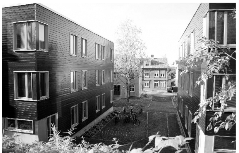
Nedre Singsakerslette studentby noen hundre meter nordvest for campus Gløshaugen ved NTNU i Trondheim var preget av forfall inntil PKA og Eggen Arkitekter, samt Løvetanna Landskap, i 1998 fikk i oppdrag av Student-samskipnaden i Trondheim å dels rehabilitere bygningsmasse som går helt tilbake til 1860-tallet, dels bygge nytt på det sentrumsnære og tradisjonsrike området. Utbygningsperioden varte i ti år, og det ferdige resultatet ble belønnet med Trondheim kommunes Byggeskikkpris for 2009.
