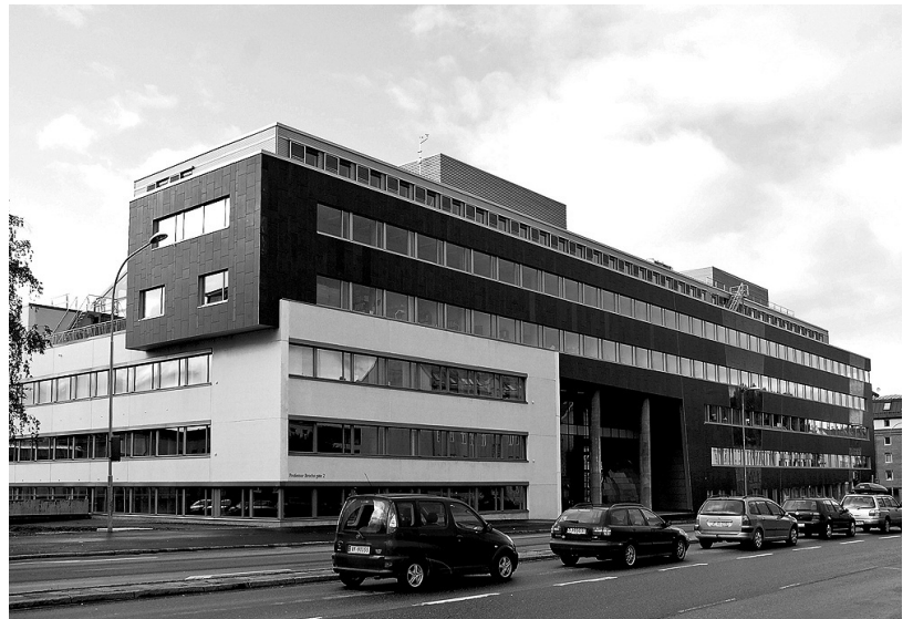
For Miljøbygget i Teknobyen, Trondheim, mottok Per Knudsen Arkitektkontor AS den prestisjetunge prisen for Årets Bygg i Norge i 2009. Bygget er landets mest energigjerrige kontorbygning med et beregnet energiforbruk på 83 kWh per kvadratmeter per år.
