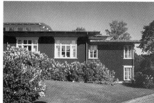
21. Del av byggnaden.
