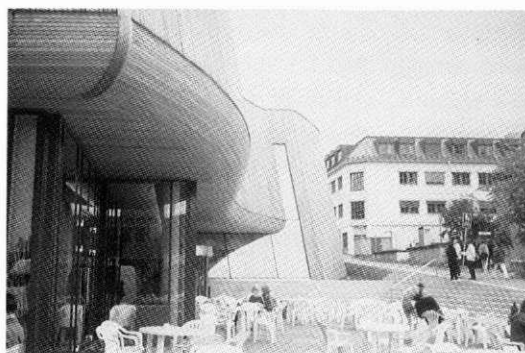
1. Den kurvande entréfasaden mot torget.
