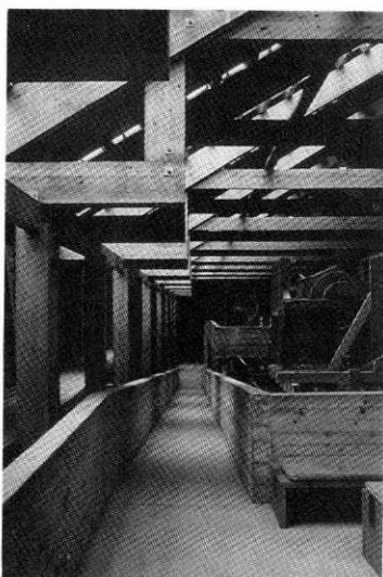
15. Takstol och betongramp separeras.
