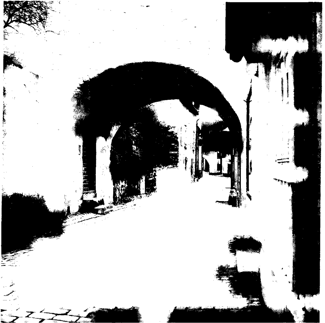
S:t Hansgatan i Visby med medeltida stenhus. I den fullbyggda staden har gatorna på flera ställen välvts över för att skapa ytterligare lager- eller bostadsutrymme.
