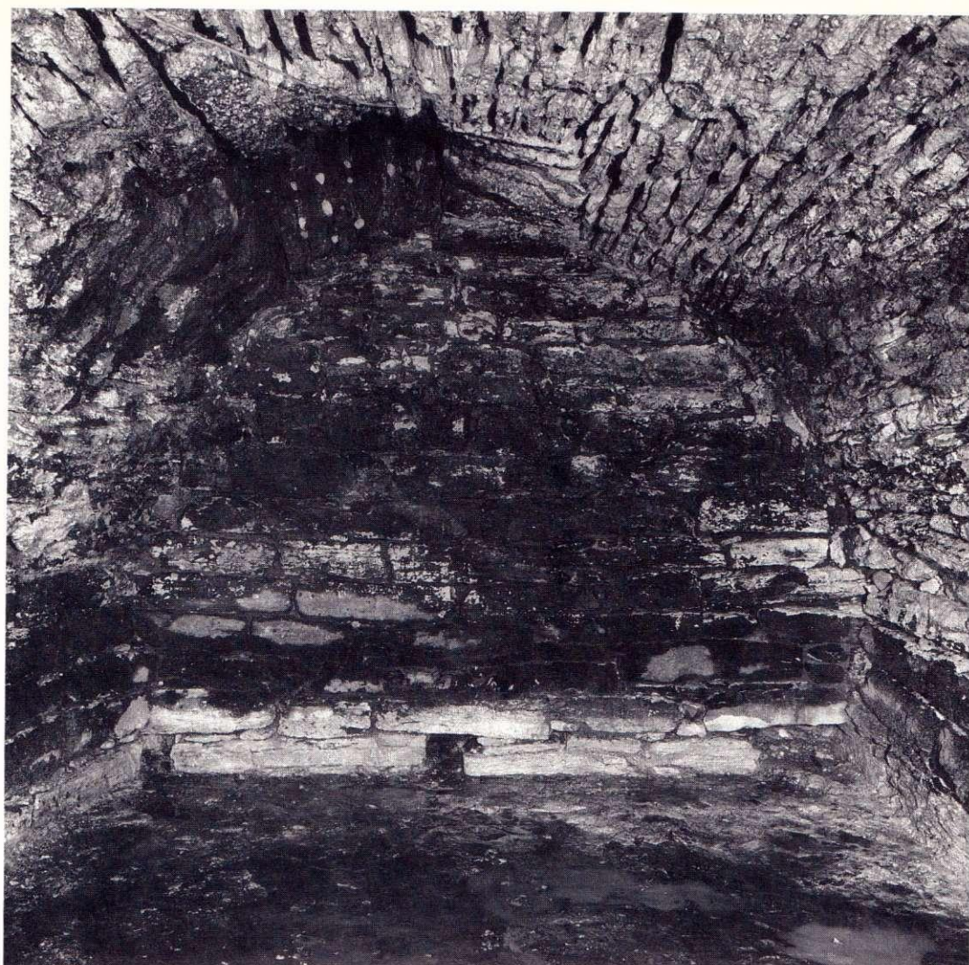
Tunnvälvd latrinkammare i Kv. Gråbrodern 4. Då kammaren tömts på avfall blev en öppning frilagd i undre skiftet i gavelns murverk. Genom öppningen strömmade vatten in i kammaren. Foto: Nils-Gustav Nydolf.
