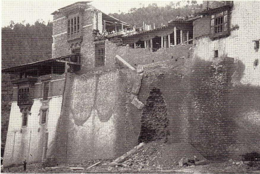
Konfliktfullt møte mellom gammel og ny teknologi under ombygningsarbeidene ved Punakha Dzong.
