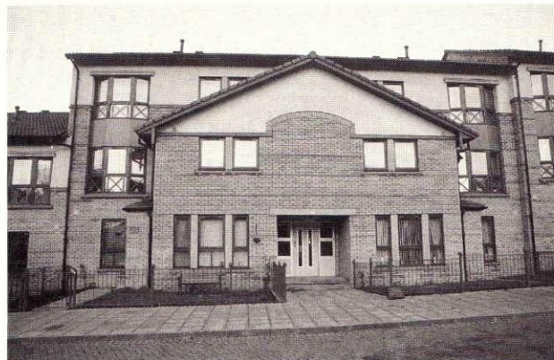
Ombyggda bostadshus med omfattande åtgärder
