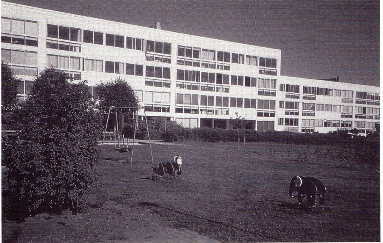
Figur 1: Arkitekt Poul Fræhr Hansen, der har stået bag renoveringen af denne bebyggelse, har tydeligvis fundet inspiration i den tidlige funktionalisme. (Varbergparken, Haderslev).
