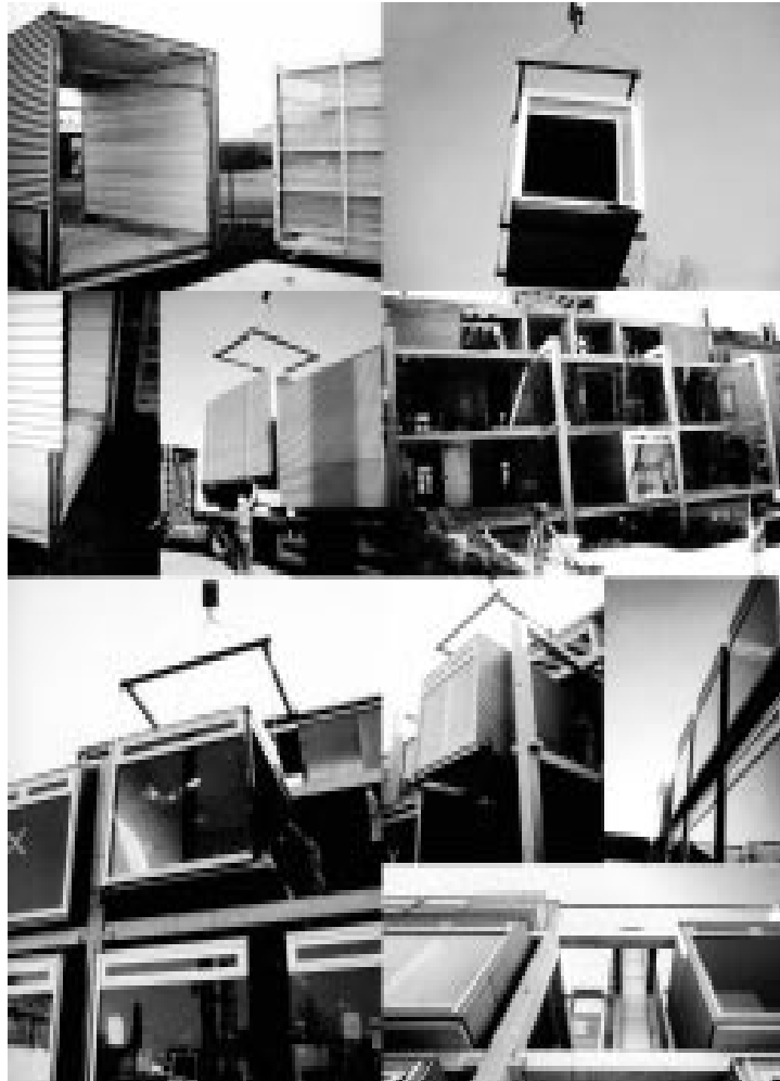
Montage af bolig- og kontorhus i Rathenow. Arkitekter: Klaus Sill og Jochen Keim. Kilde: Quaderns, 227/2000
