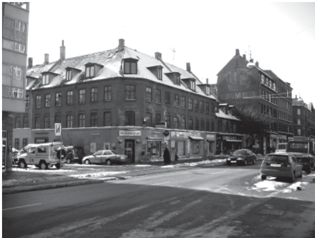
Den lave bebyggelse Holmbladsgade 24–30/Geislersgade 2–6 på Amagerbro i København, der rummer det stemningsfulde værtshus "Sommerlyst", afventer nedrivning – vedtaget i forbindelse med byfornyelsen af Holmbladsgade-området. Bemærk fortælleverdien i den tilbagerykkede gadelinie og i kontrasten til nabo-husets 5-etages gavll.
